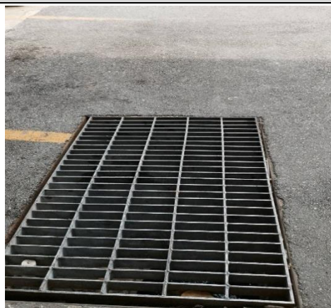
รูปที่ 2-9 การเชื่อมต่อระบายน้ำของโครงการกับท่อระบายน้ำสาธารณะ
